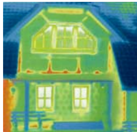
Nach dem Einbau – neue Weru-Fenster.
