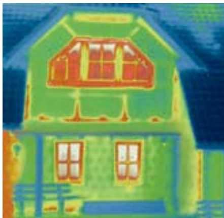
Vor dem Einbau – alte Kunststoff-Fenster.
