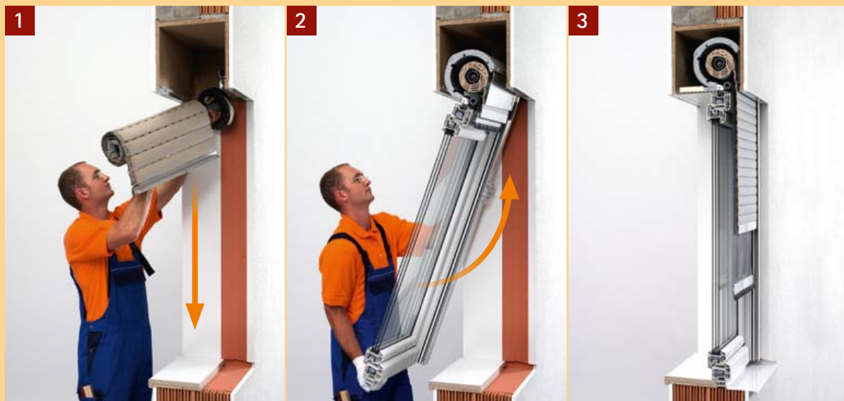
1 Alten Rollladen aus Kasten entfernen!
