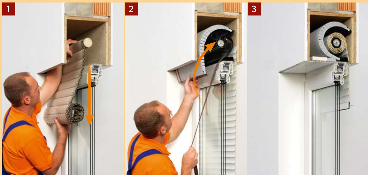
1 Alten Rollladen aus Kasten entfernen!
